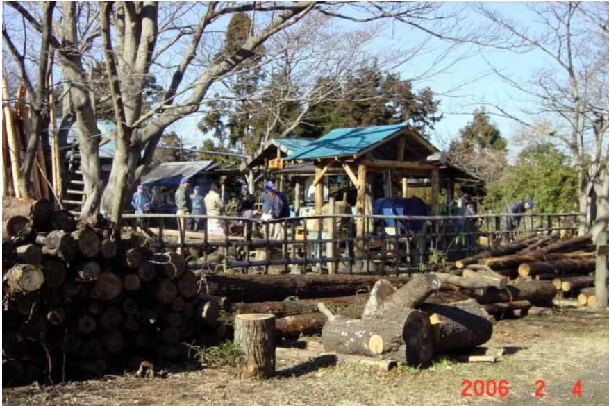
炭焼設備 全景
